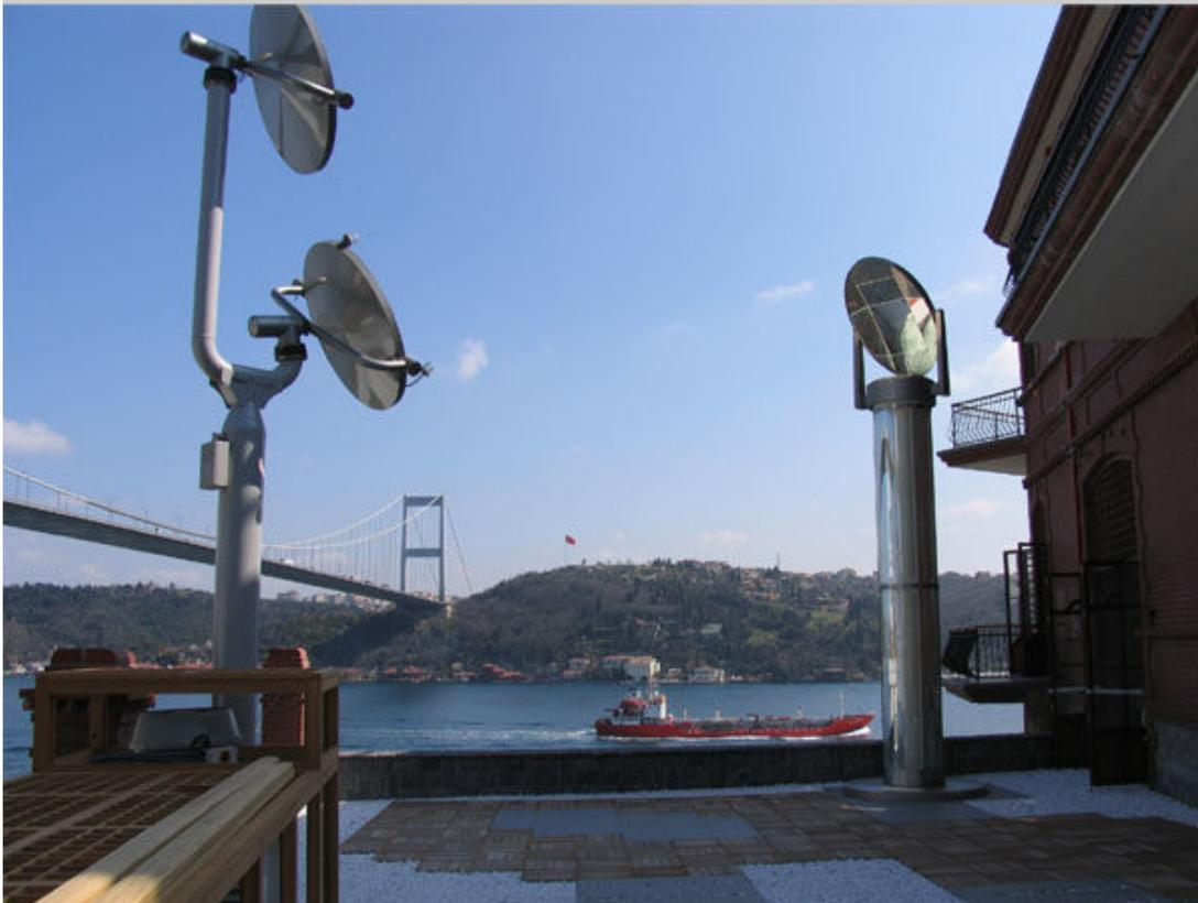
Le système à double Heliostat et miroir fixe ,
